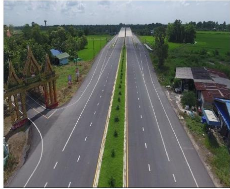
เสาไฟฟ้า
