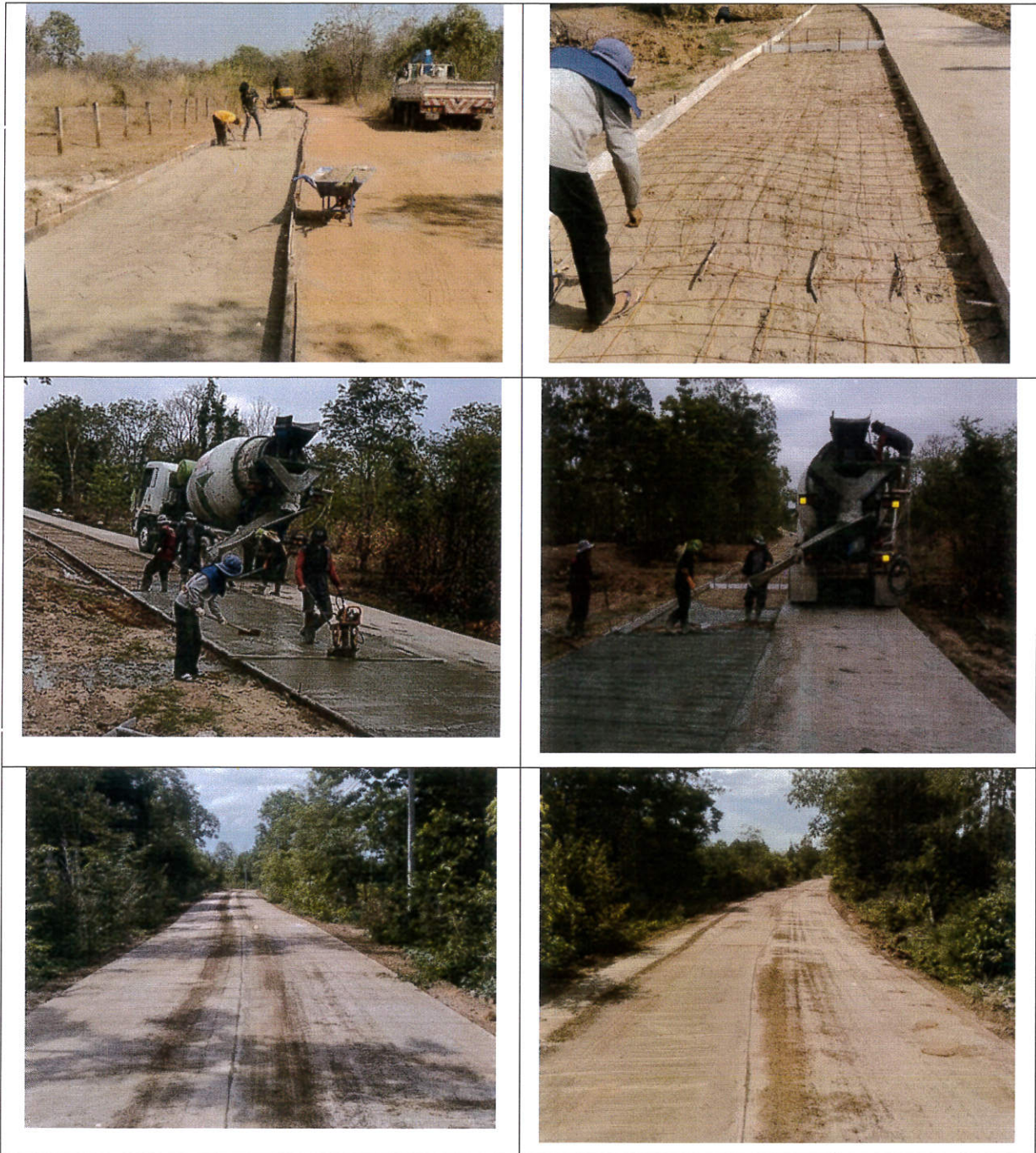
ภาพถ่าย โครงการก่อสร้างถนนคอนกรีตเสริมเหล็ก สายข้างวัดศรีโนนสัง ม.8 บ้านโนนศิลา ถึงถนนสายวัดป่าเทพนิมิตร ม.13 ประจำปี พ.ศ. 2566
