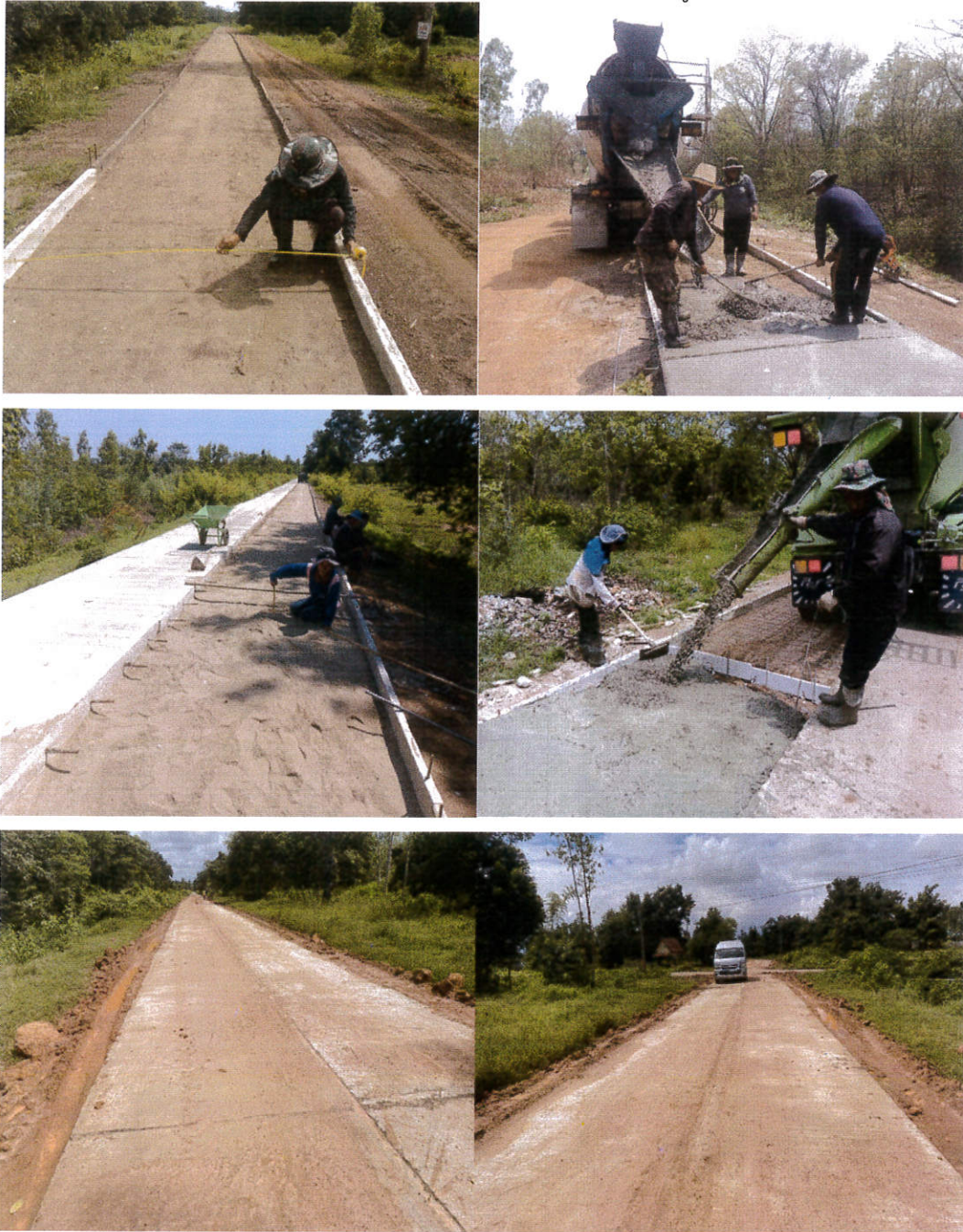
ภาพถ่าย โครงการก่อสร้างถนน คสล.ภายในชุมชนเขตเทศบาล รหัสทางหลวงท้องถิ่น นก.ถ.15011 สายคลองซอยหมู่ที่ 15 ประจำปี พ.ศ. 2566
