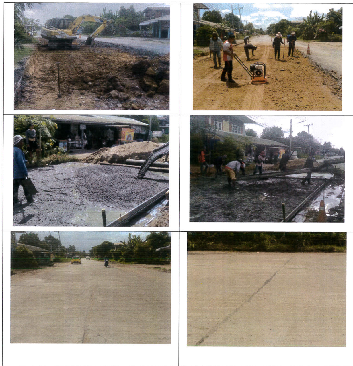
ภาพถ่ายโครงการซ่อมแซมถนนคสล. สายประชาอุทิศ ประจำปี พ.ศ.2566
