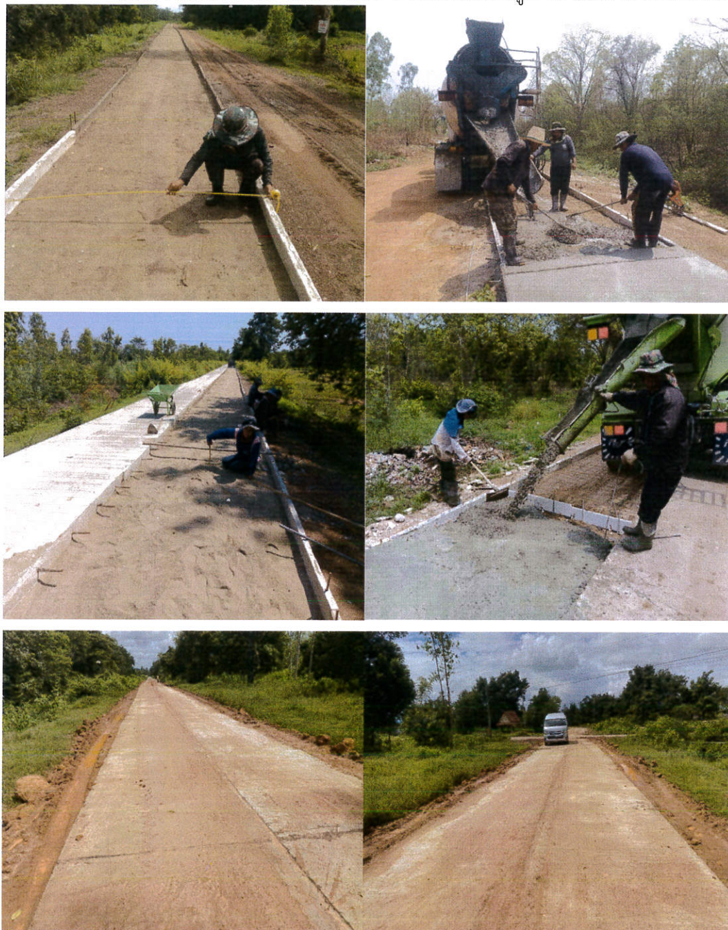
ภาพถ่าย โครงการก่อสร้างถนน คสล.ภายในชุมชนเขตเทศบาล รหัสทางหลวงท้องถิ่น นก.ถ.15011 สายคลองข่อยหมู่ที่ 15 ประจำปี พ.ศ. 2566
