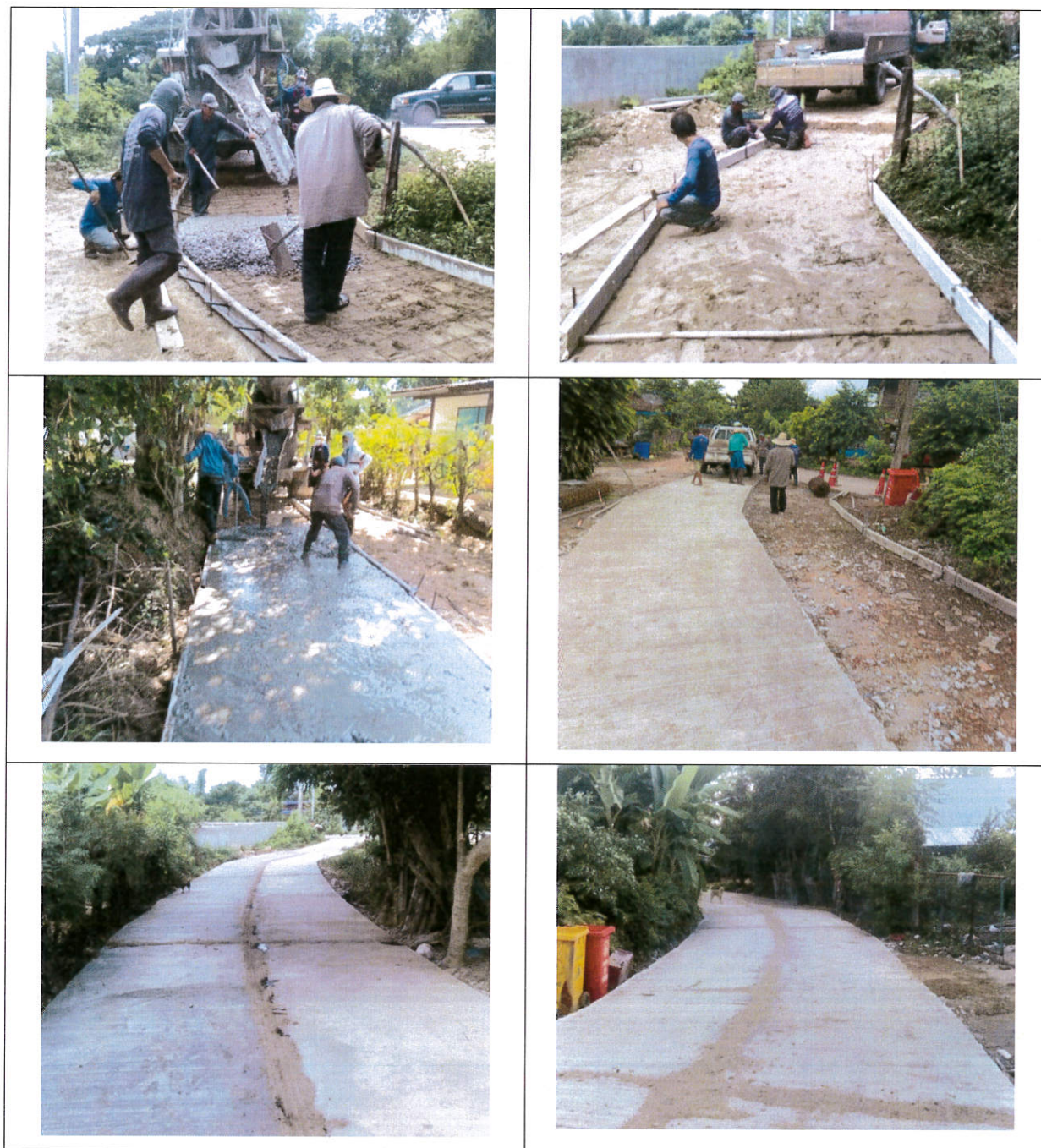
ภาพถ่าย โครงการก่อสร้างถนนคอนกรีตเสริมเหล็กภายในเขตเทศบาล สายข้างร้านตัดผมศรีจันทร์ ม.1 ประจำปี พ.ศ. 2566
