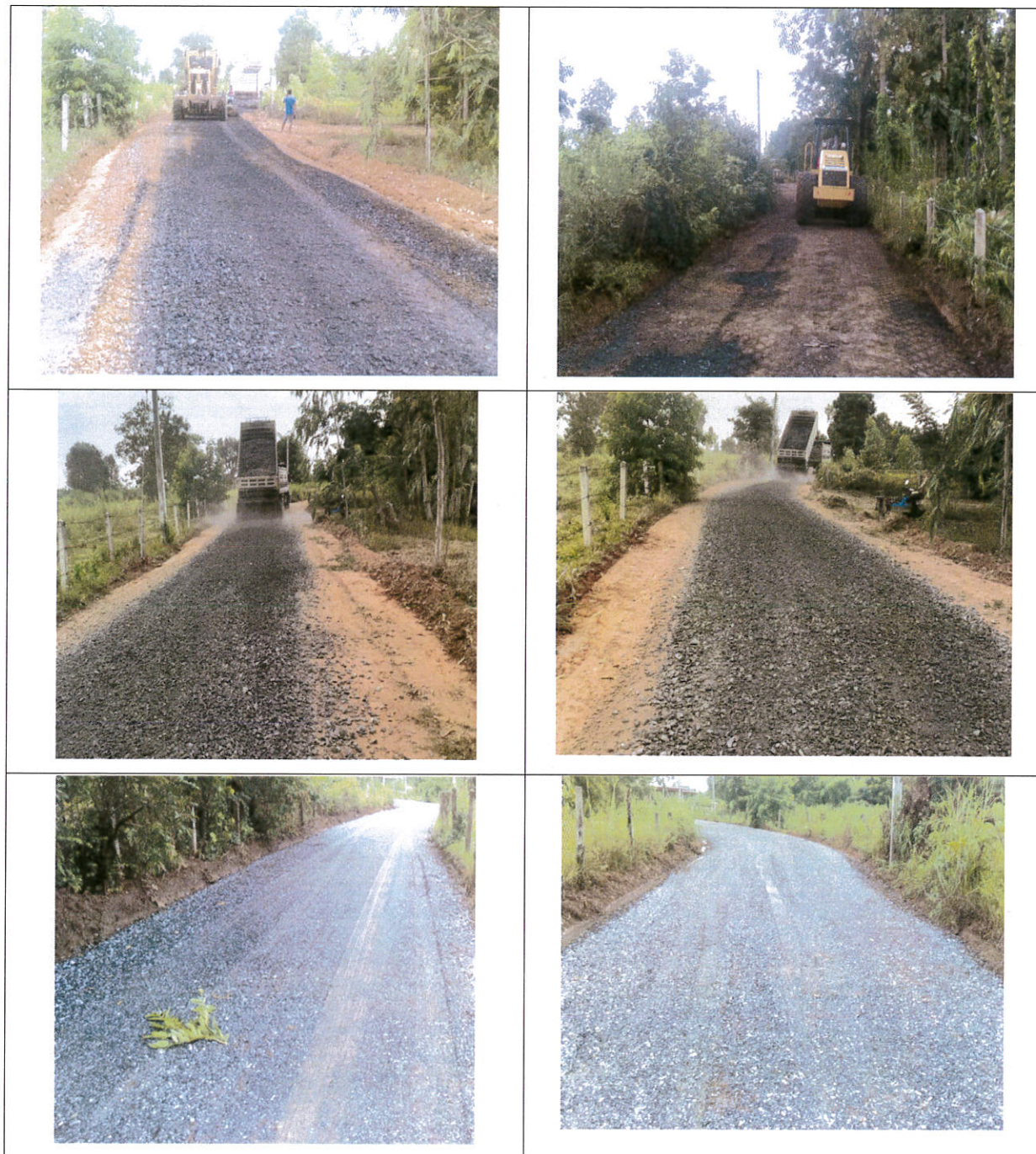
ภาพถ่าย โครงการก่อสร้างถนนหินคลุกภายในเขตเทศบาลสายนายนบุญชู ถึงนายนายสวัสดิ์ บ้านโสกจาน ม.13 ประจำปี พ.ศ. 2566
