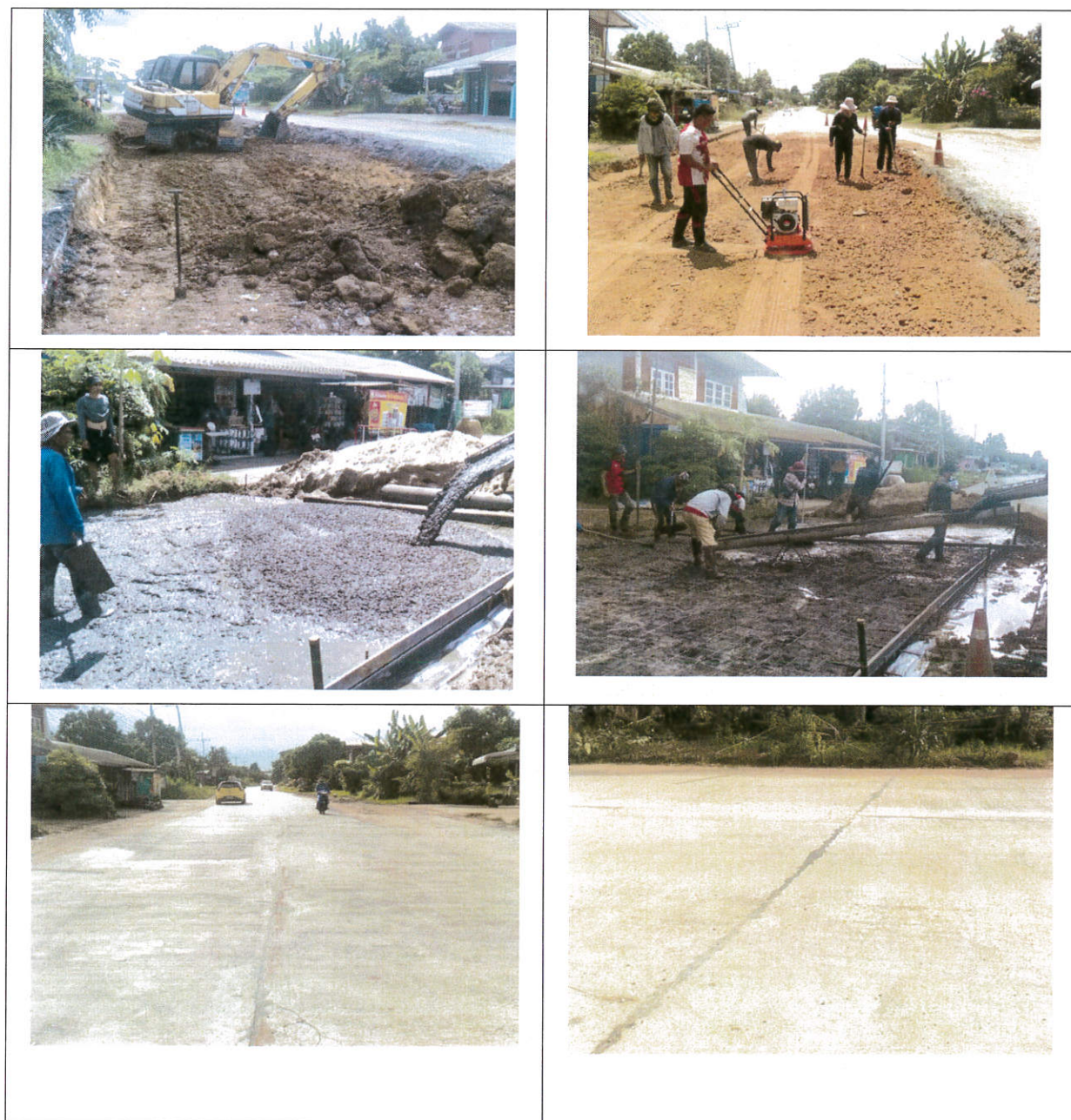
ภาพถ่ายโครงการซ่อมแซมถนนคสล. สายประจักษ์ ประจำปี พ.ศ.2566
