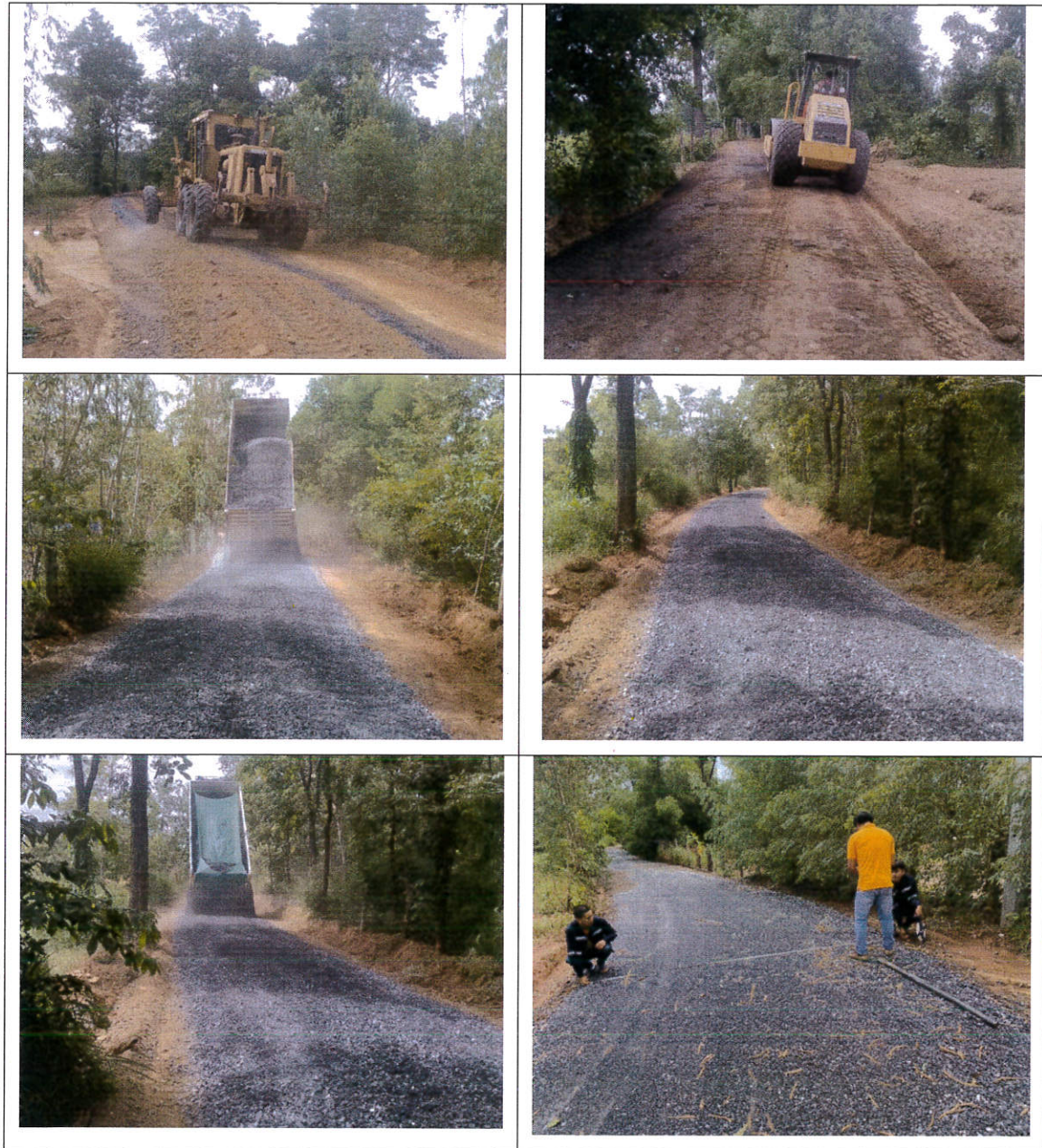
ภาพถ่าย โครงการก่อสร้างถนนหินคลุกภายในเขตเทศบาลสายหนองไผ่บ้านโสกจาน ม.13 ประจำปี พ.ศ. 2566
