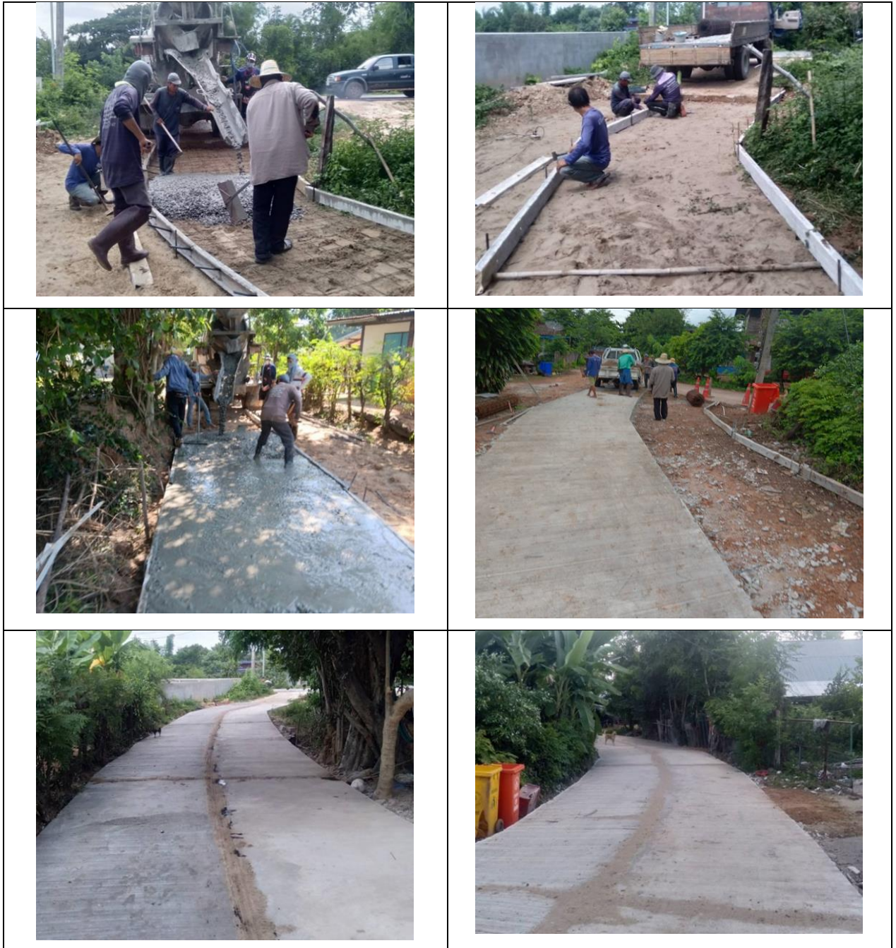
ภาพถ่าย โครงการก่อสร้างถนนคอนกรีตเสริมเหล็กภายในเขตเทศบาล สายข้างร้านตัดผมศรีจันทร์ ม.1 ประจำปี พ.ศ. 2566
