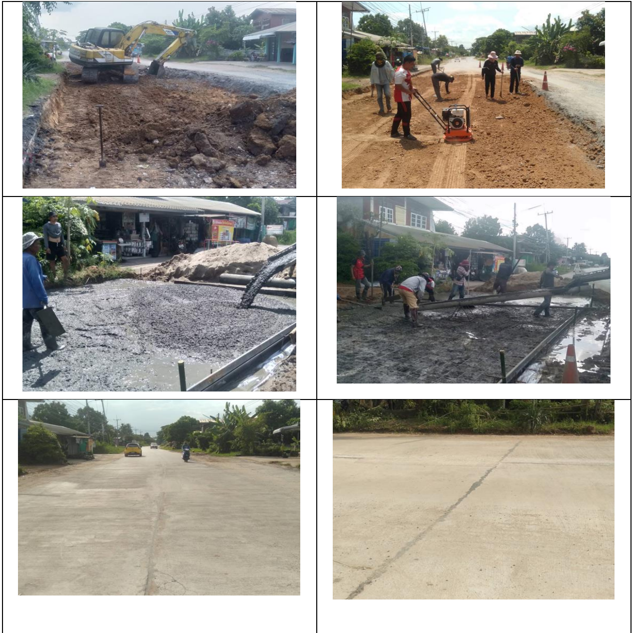
ภาพถ่ายโครงการซ่อมแซมถนนคสล. สายประจักษ์ ประจำปี พ.ศ.2566
