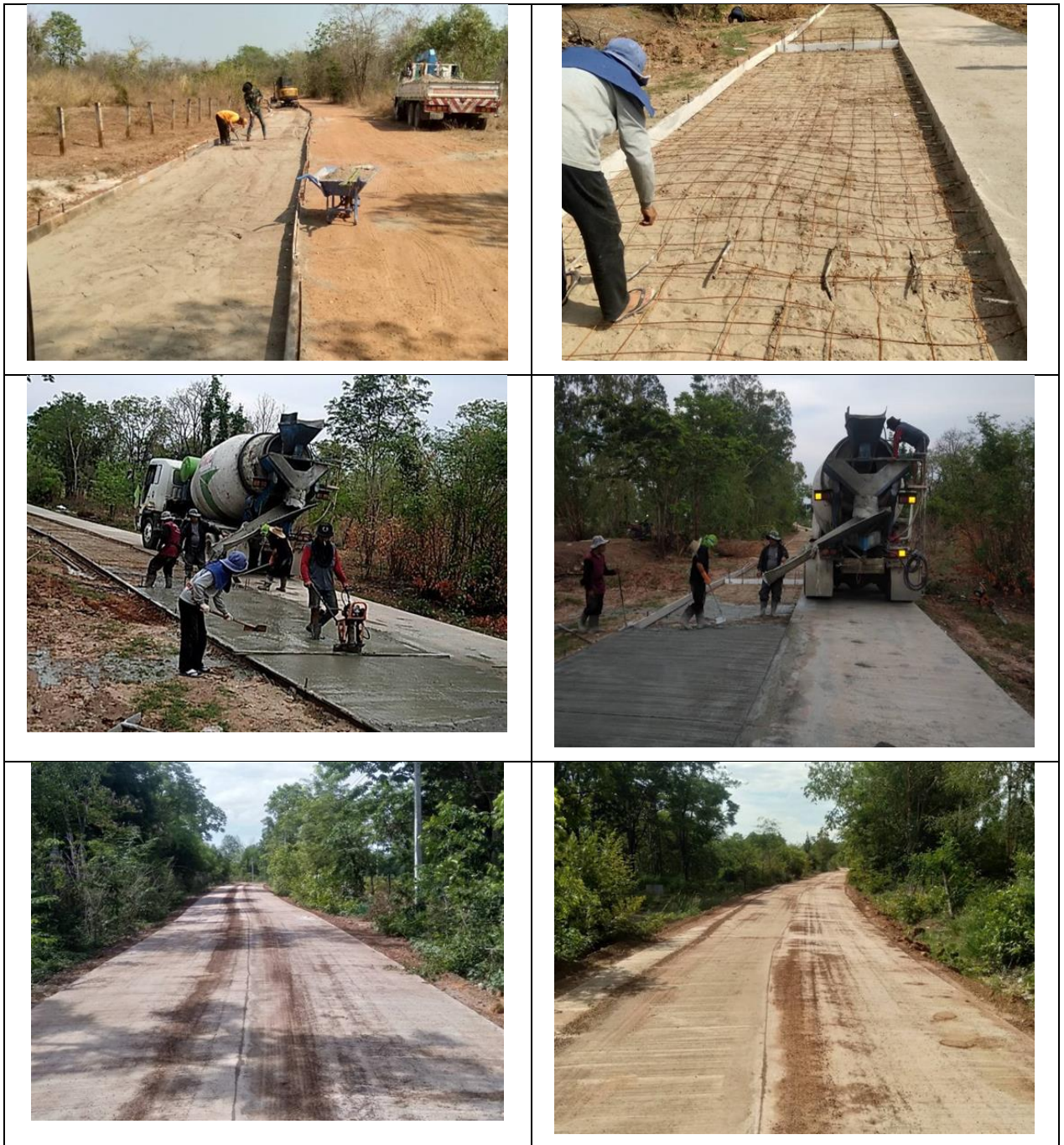
ภาพถ่าย โครงการก่อสร้างถนนคอนกรีตเสริมเหล็ก สายข้างวัดศรีโนนสัง ม.8 บ้านโนนศิลา ถึงถนนสายวัดป่าเทพนิมิตร ม.13 ประจำปี พ.ศ. 2566
