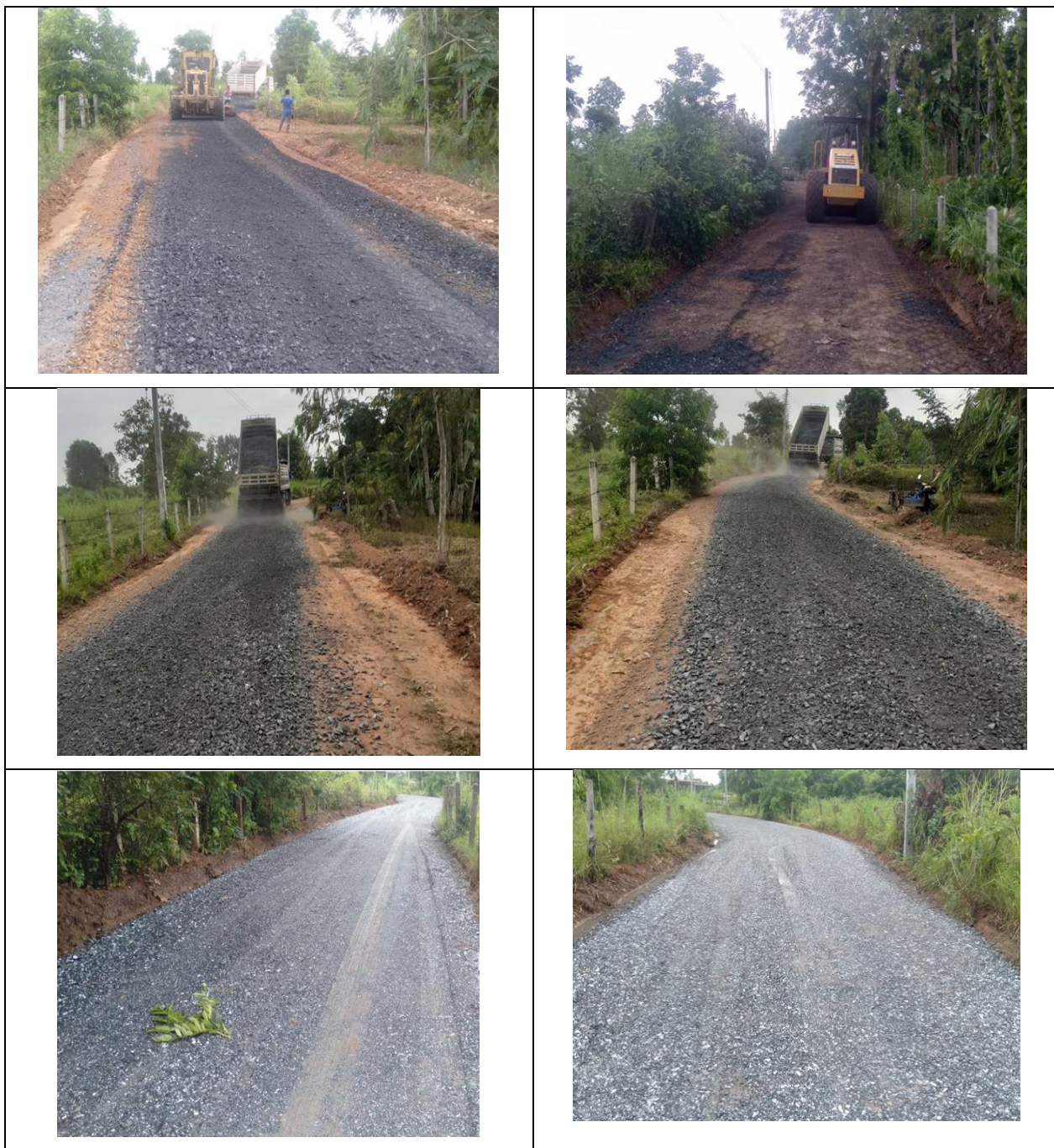
ภาพถ่าย โครงการก่อสร้างถนนหินคลุกภายในเขตเทศบาลสายนายนายบุญชู ถึงนายนายสวัสดิ์ บ้านโสกจาน ม.13 ประจำปี พ.ศ. 2566
